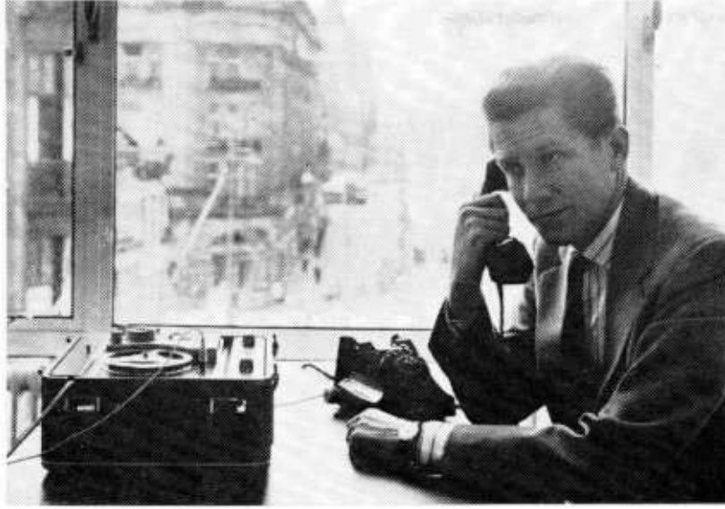
Foto 19. Het opnemen van belangrijke telefoongesprekken met behulp van een recorder. Links aan de zijkant van het telefoontoestel bevindt zich een kleine van een zuignap voorziene telefoonspoel. Het inkomende, zowel als het uitgaande gesprek kan worden opgenomen door de telefoonspoel in plaats van de microfoon met de recorder te verbinden. Omgevingsgeluiden worden niet opgenomen.
